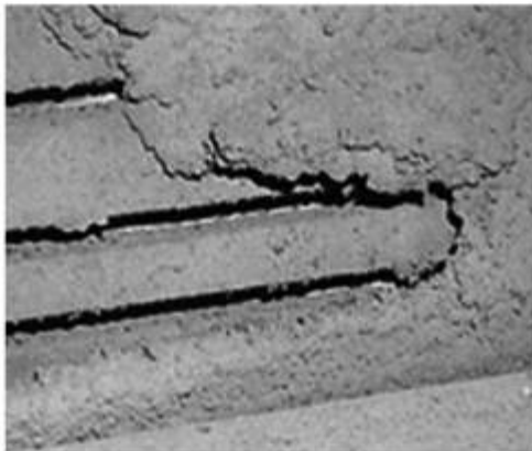
Intonaci applicati a spruzzo per il rivestimento di superfici (ad es. di soffitti oppure di strutture metalliche, travi) allo scopo di aumentare la resistenza al fuoco
