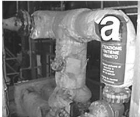
Rivestimenti di tubazioni per il trasporto di fluidi ad alta temperatura costituiti da avvolgimenti di nastri in tessuto contenente amianto, oppure impasti di tipo gessoso
